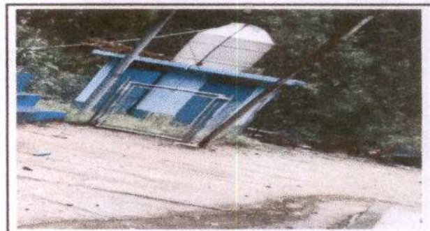
Foto 6: Sustitución de deposito de agua 1700 lt
